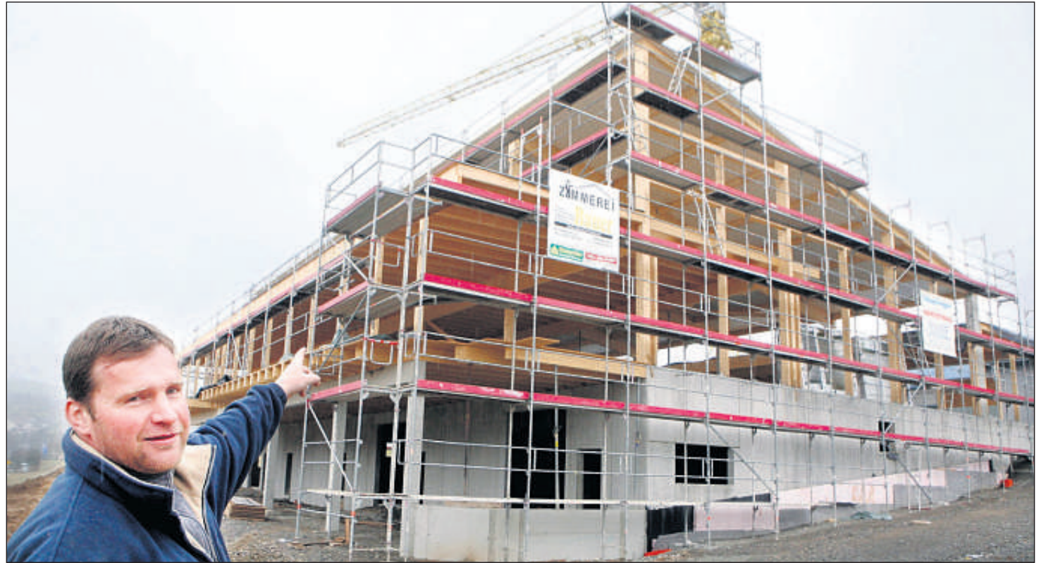
13 Meter hoch und mit 1300 Quadratmetern Ausstellungsfläche: Ralf Blessing zeigt die Baustelle seines Handwerker-Hauses.
